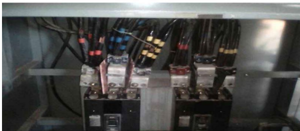
Reparación de la Planta Eléctrica
