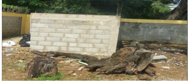
Construcción Del Area Y El Perímetro Del Area De Desechos
