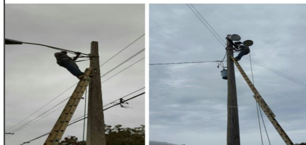
Reparacion e Instalacion de Iluminacion Perimetro Interior
